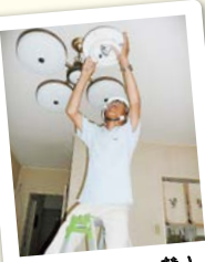
蛍光灯の取り替え
